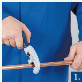
1. Odciąć rurę pod kątem prostym.
